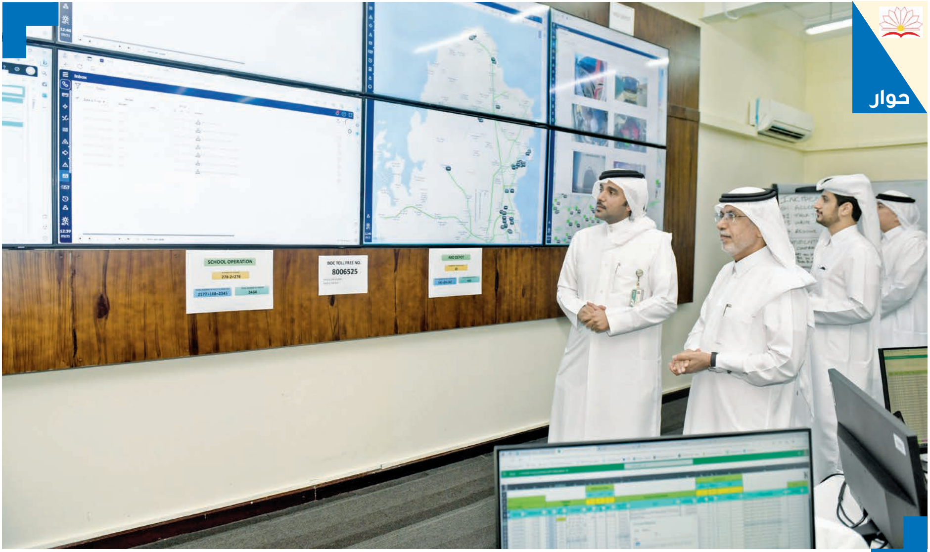
من داخل غرفة المراقبة الرئيسية
