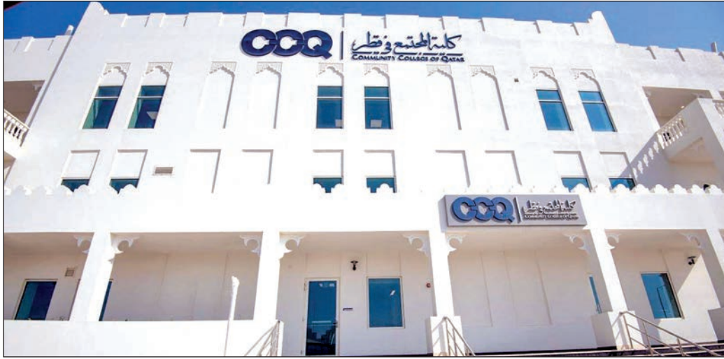
■ مبنى كلية المجتمع للبنات
