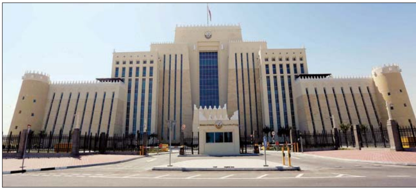
مبنى وزارة الداخلية
