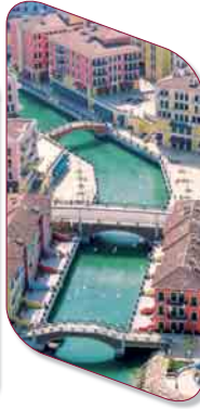
QANAT QUARTIER THE PEARL - QATAR
