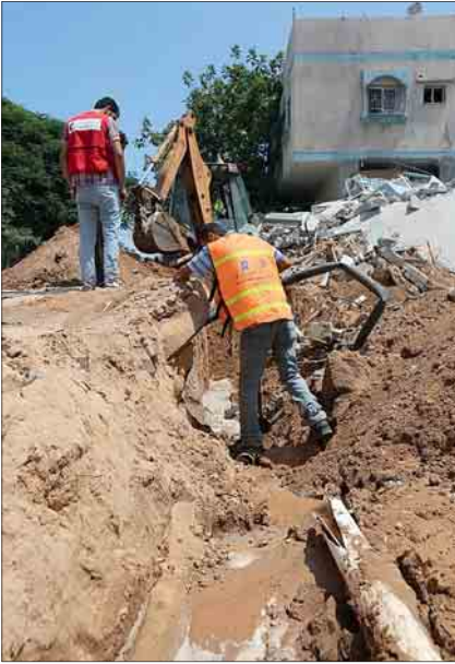
إعادة تأهيل شبكات المياه
