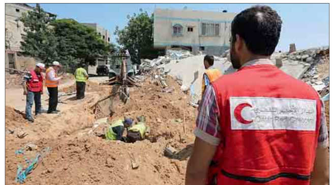
إعادة تأهيل شبكات المياه
