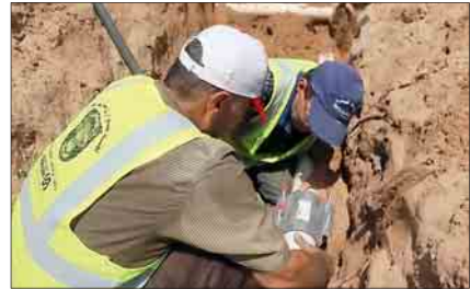
إعادة تأهيل شبكات المياه
