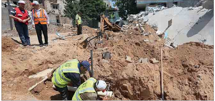
إعادة تأهيل شبكات المياه
